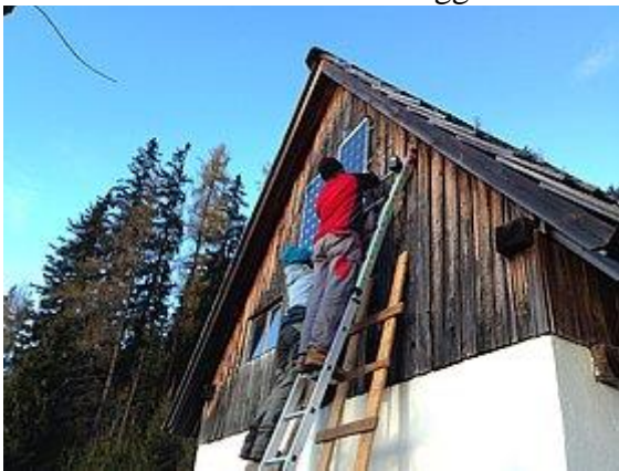
Befestigung der Solarmodule
